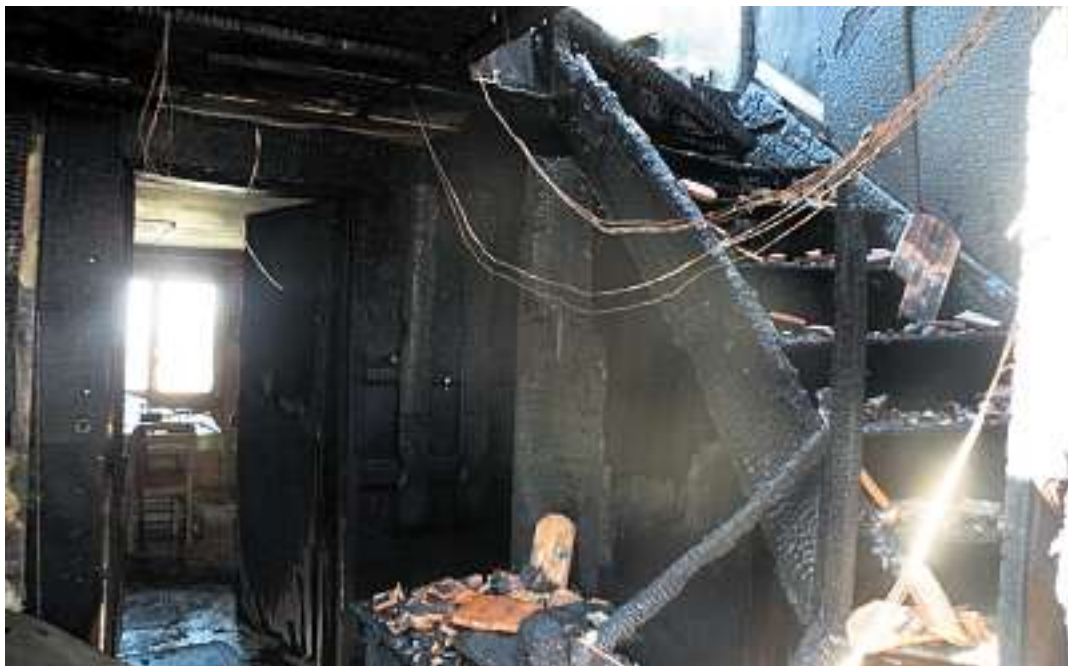
Das Treppenhaus und die Küche im Hintergrund: Unter dieser Treppe befindet sich der Zugang zum Untergeschoss, wo das Feuer ausbrach.
